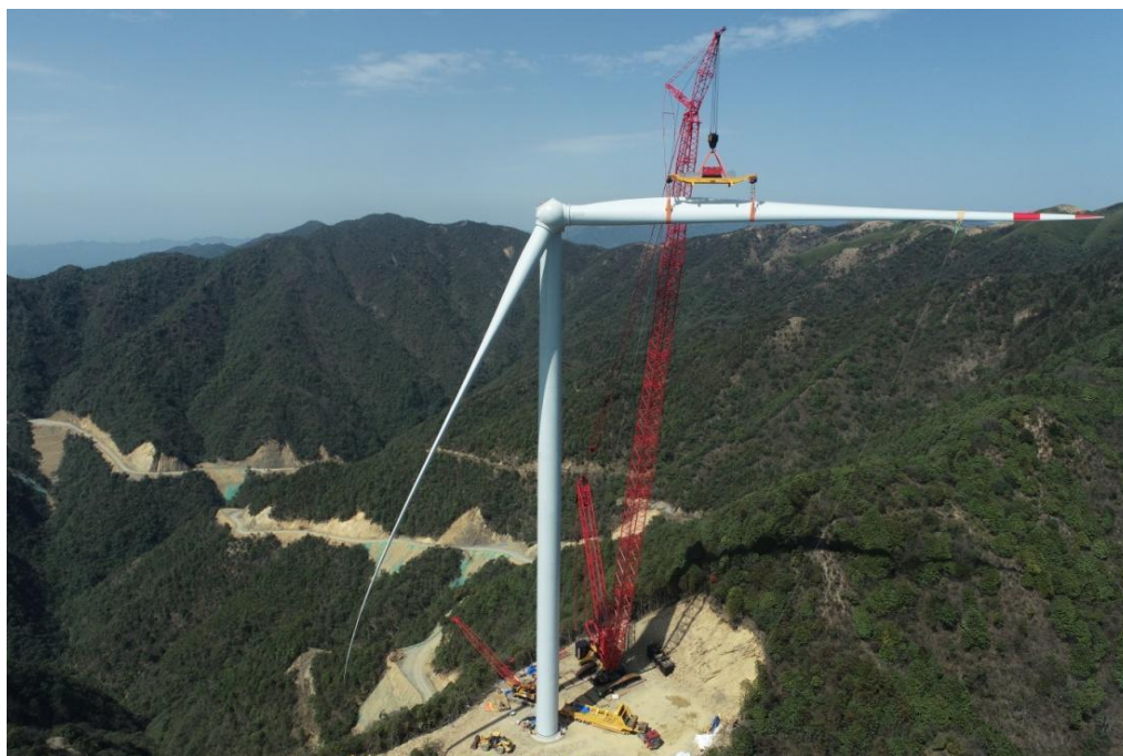
图 2-2 单叶片吊装实景图
