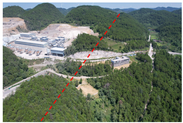
迁改工程线路及彭家湾石场矿区
