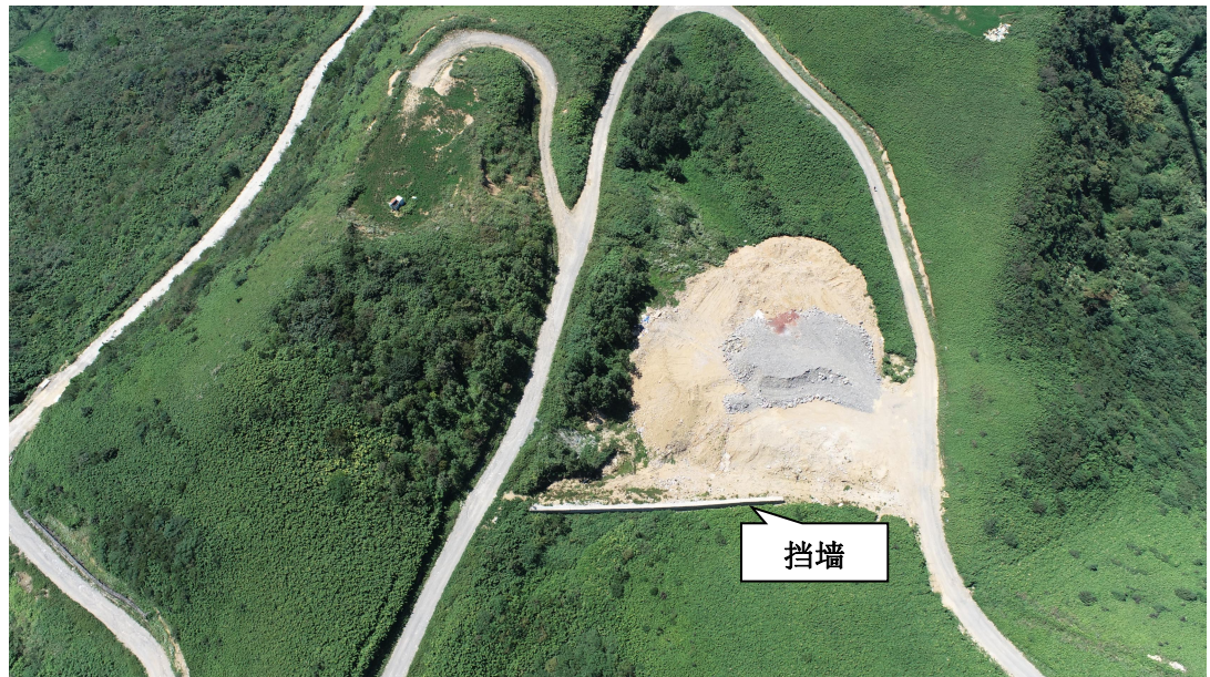
图 2.4-1 和顺风电 1#渣场现状
