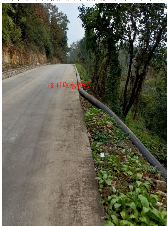
图 2.2-3 压裂供水临时软管敷设示例图
