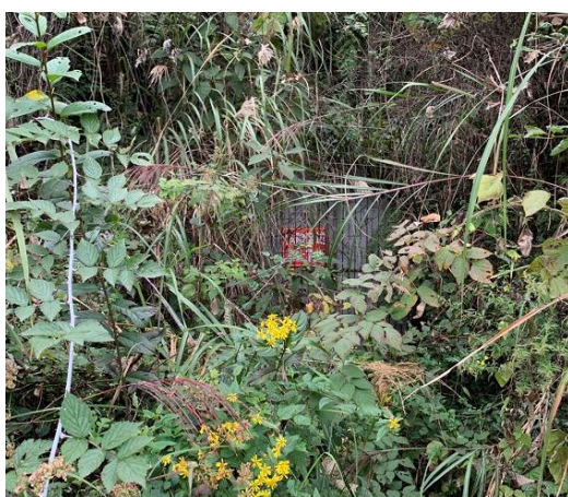
风井口（封闭状态）
