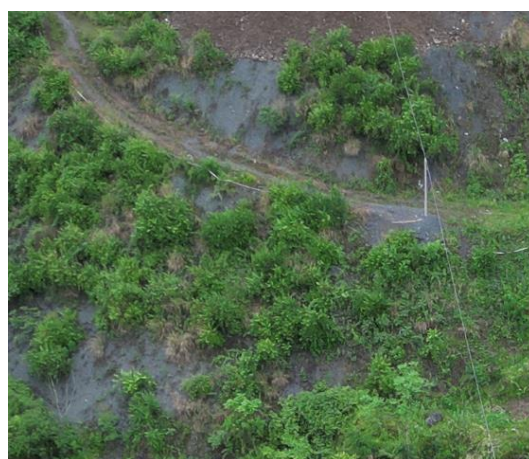
渣石堆场形成的斜坡
