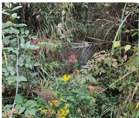
风井口（封闭状态）
